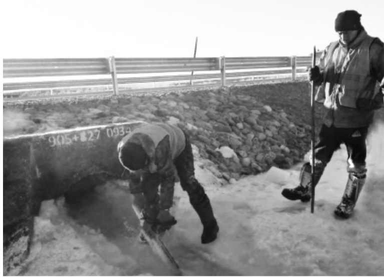
Идут ледорезные работы
