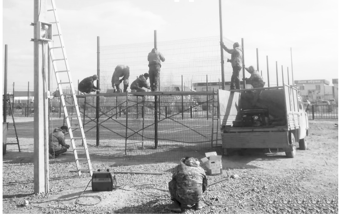
Сотрудники МКУ «Тепло» устанавливают ограждение
